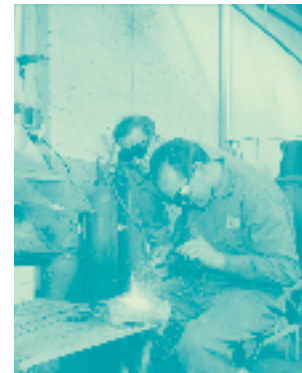
Standard telefon- og kabelfabrikk, produksjonslokale, 1957. Foto: Leif Ørnelund, Oslo Bymuseum
